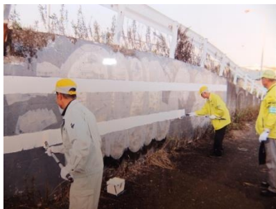
大庭大橋＝白線二本で落書き否定
